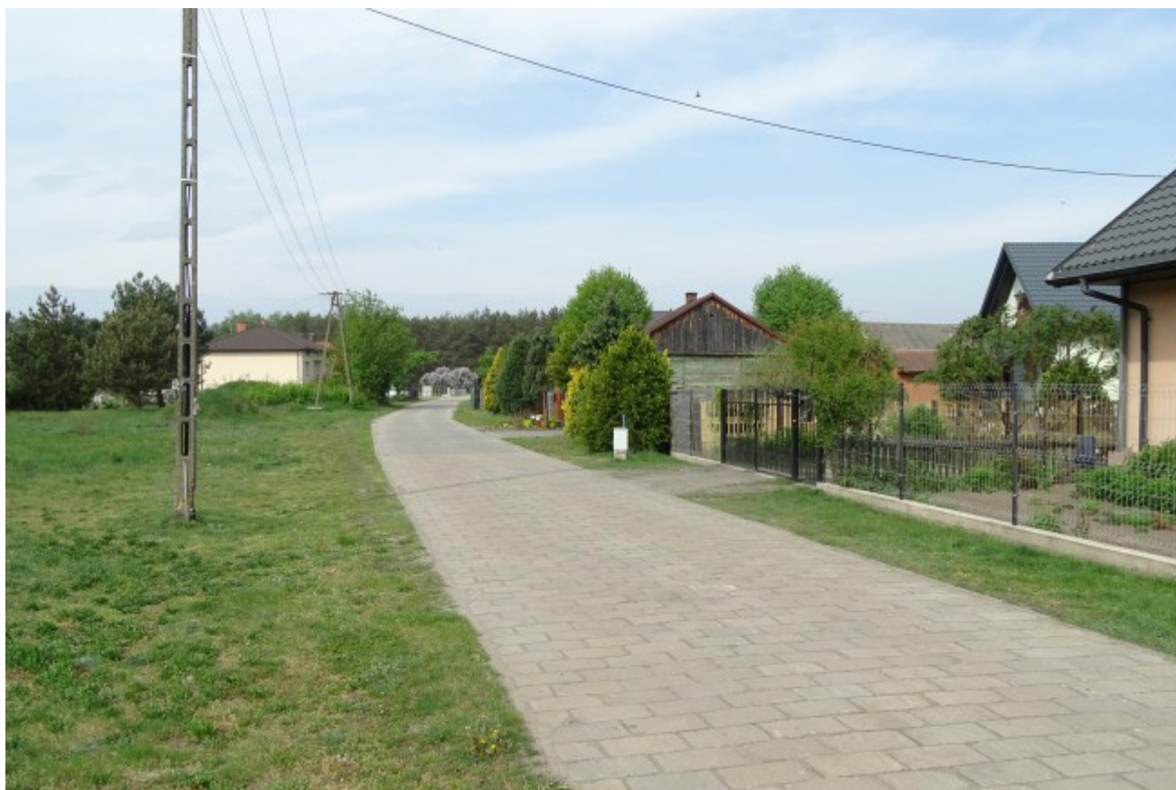
9. Remont drogi w miejscowości Zajezerze - ul. Zielona, o szerokości 4 m" Koszt zadania: 59 994,67 zł
