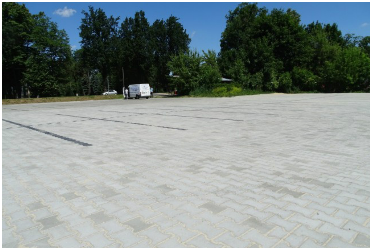
3. Przebudowa drogi gminnej na ul. Ogrodowej w Zajezerzu. Łączny koszt brutto: 39 294,00 zł
