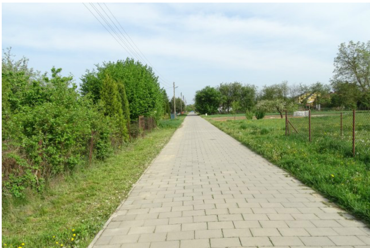
4. „Remont przepustów w drodze gminnej w miejscowości Słowiki Folwark - sztuk 3 oraz remont przepustów w drodze gminnej w miejscowości Słowiki Stare - sztuk 2” Koszt zadania: 5 890,00 zł.
